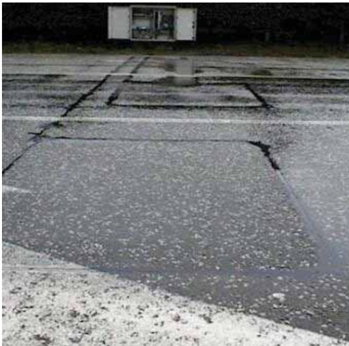
Figuur 1 Inductielus aangebracht in de toplaag van de rijbaan
