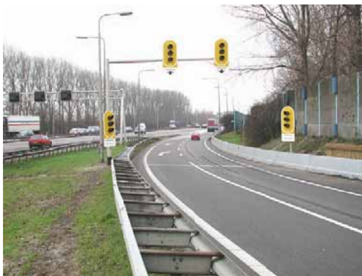
Figuur 9 Toeritdosering
